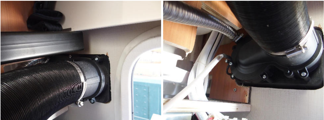
il camino visto dall'interno, con la parete bagno tagliata
