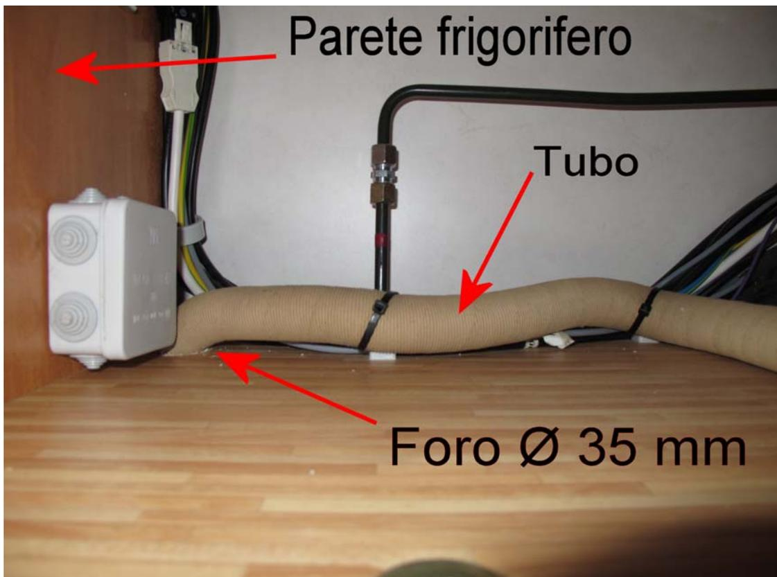
Arrivato alla parete che divide dal vano del frigo, il tubo attraversa il pavimento con un foro da 35mm Ø e va sotto nel vano dell'EFOY.
