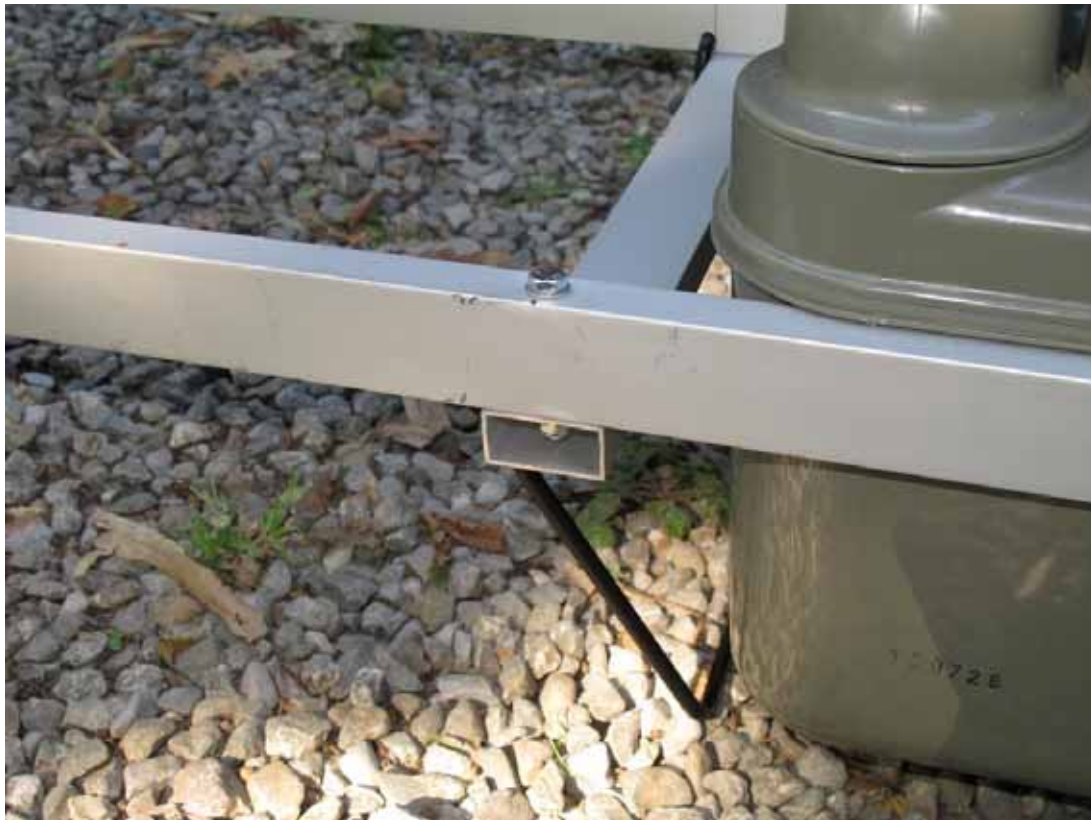
FOTO 5 : il fissaggio della traversa anteriore
